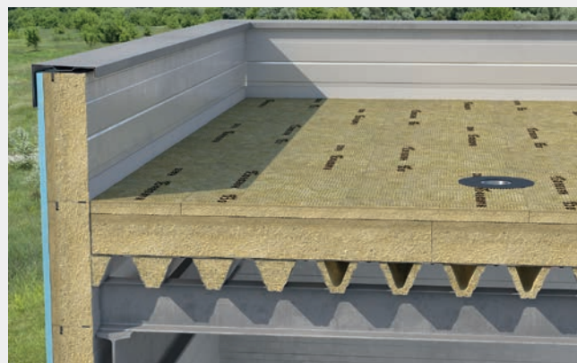
Układanie warstwy wierzchniej ocieplenia z płyt HARDROCK MAX na sucho.
